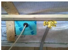
Entourage des baies : continuité étanchéité air, traitement pont thermique tableau et appui de fenêtre...
